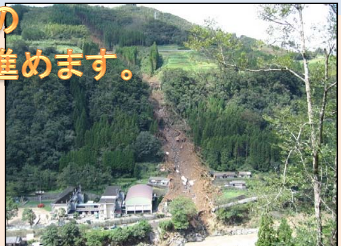
平成17年 台風第14号による山地災害
