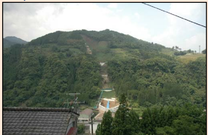
治山事業により崩壊地を森林に復旧
