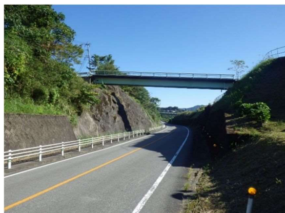
図 9 国道を跨ぐ橋梁の例（日之影町管理 袴谷中橋）
