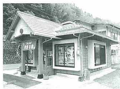
◀ 整備された列車の宿「事務所兼観光案内所」
