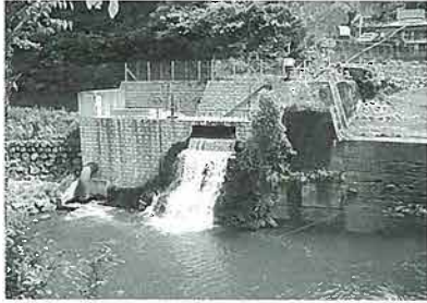
小水力発電施設
