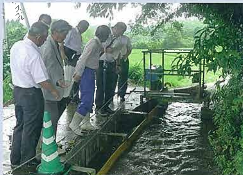
竹田市『小水力発電施設』現地説明を聞く
