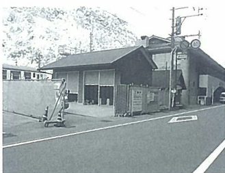
温泉駅ボイラー施設
