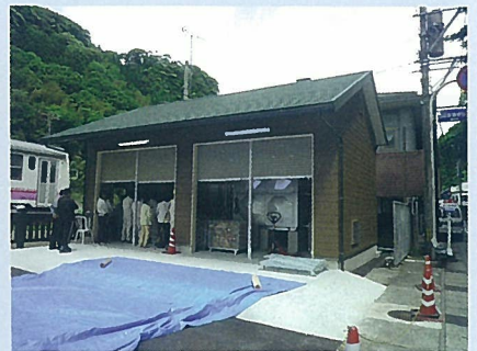
稼働が始まったボイラー建物
