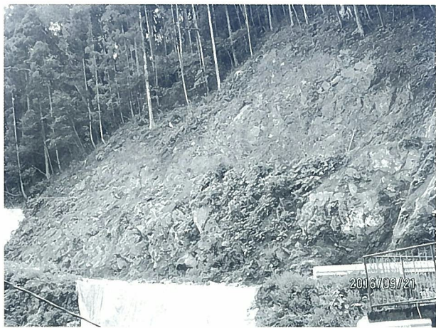
町道深角日之影線(長谷川)
