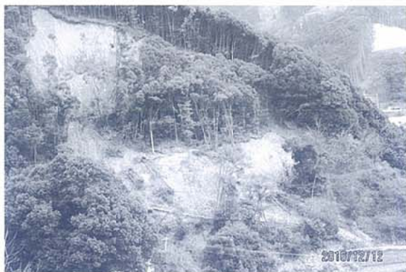
(深角西線の災害現場)
