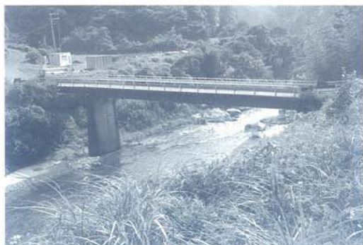
《一部修復された中川橋》
