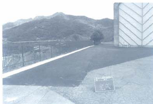
《熊本地震災で修復された中学校入口付近》
