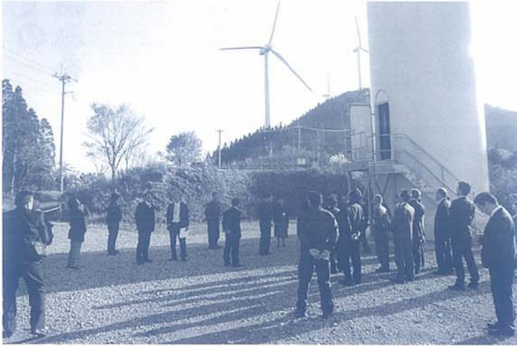
《飯干峠に建設された風車》
