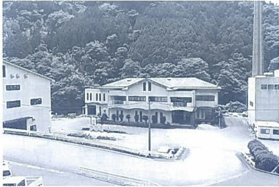
《西臼杵衛生センター(尿処理施設)》
