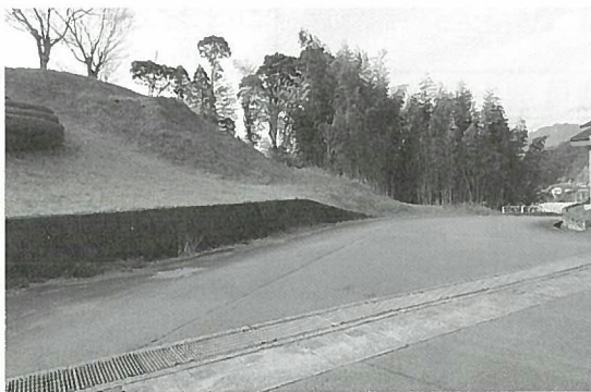
《町立病院～役場線新設工事入口付近》
