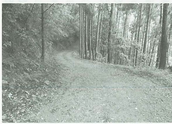
【整備が急がれる作業道】
