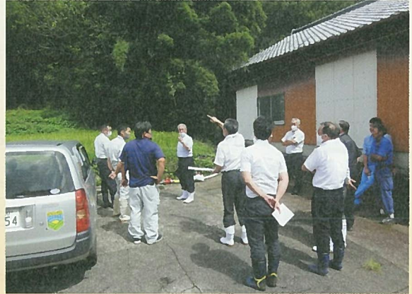
【水道管破損現場 八戸地区簡易水道】
