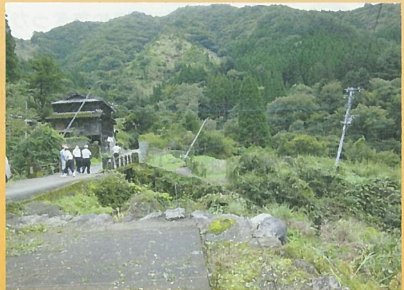
【倒木による電柱被害 煤市集落】
