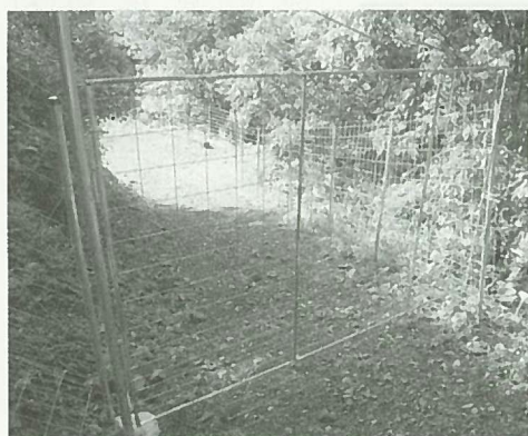
【有害鳥獣対策の金網設置】
