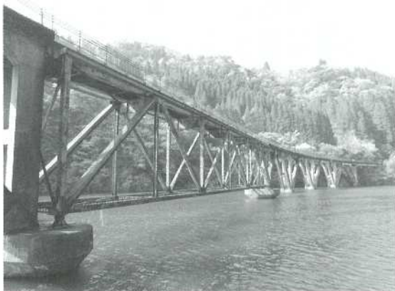
【旧第三五ヶ瀬川橋梁】
