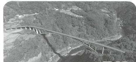
天翔大橋橋梁点検診断委託料 540万円
