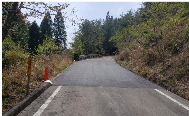
整備された林道
