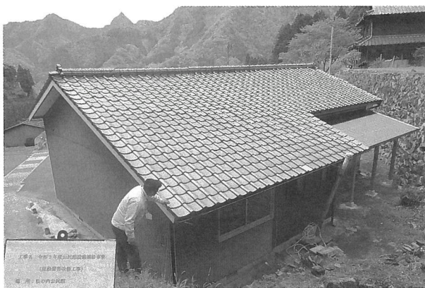
【屋根のふき替え補修後の松の内公民館】
