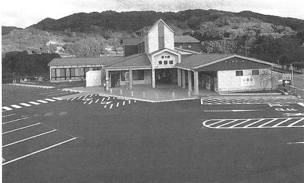
【道の駅青雲橋の全景】
