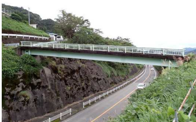
図 10 道路を跨ぐ橋梁の例（日之影町管理 袴谷中橋）
