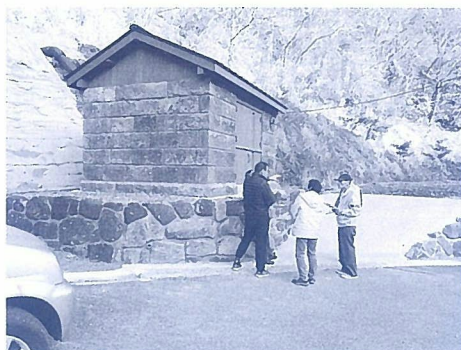
《完成した大日止鼻小水力発電所》
