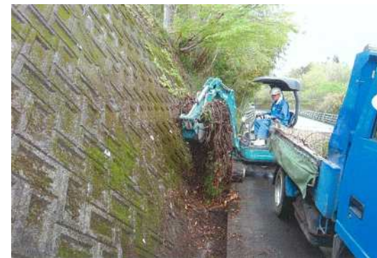
側溝清掃状況
