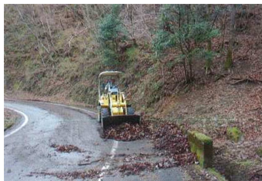
路面整備状況
