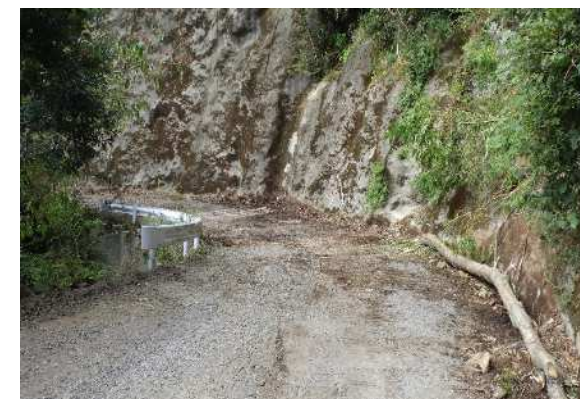
路面整備完了
