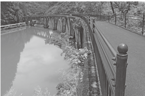
【第3五ヶ瀬川橋梁】
