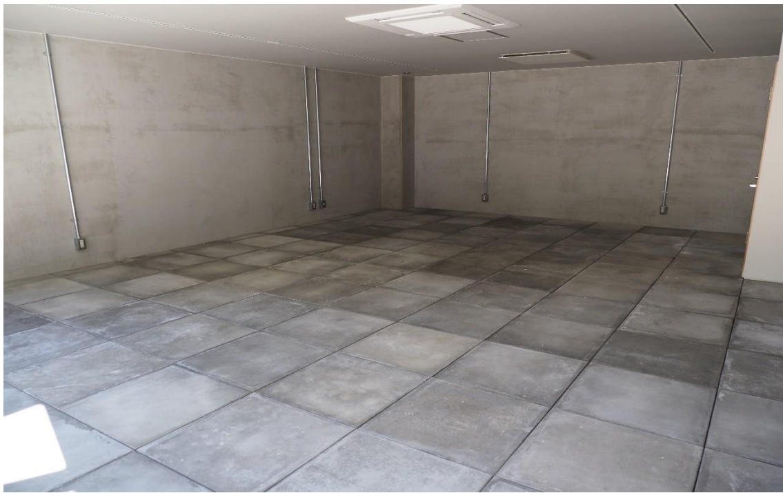
日之影町コミュニティセンター1階テナント（1） 内観
